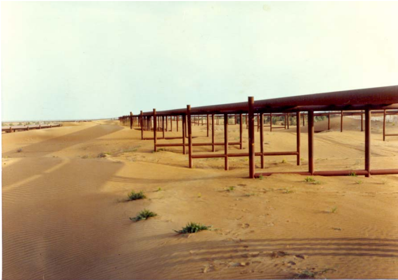
شکل شماره ۱۱-۳- لوله‌های انتقال مواد سوختی از موانع تردد ماشین‌آلات مالچ پاشی در منطقه کار است
