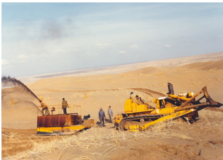
شکل شماره ۹-۱- بولدوزر مجهز به وینچ برای کشیدن اسکی
