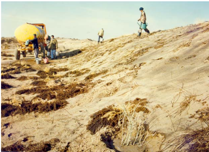
شکل شماره ۱۱-۲- حرکت بلدوزر در یک مسیر ماسه‌ای و تسطیح آن بوسیله اسکی و مالچ‌پاشی بر روی آن (شکل بالا) می‌تواند سبب ایجاد مسیرهایی شود که بعداً جهت آبیاری نهالها، مورد استفاده قرار گیرد (شکل پایین)
